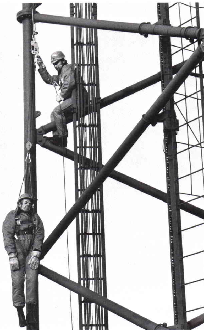
Rollgliss heter det här räddningsdonet, med vilket man med hjälp av en kamrat eller med egen kraft kan fira sig ned från hög höjd. Linrullen är utrustad med backspärr. Bromskraften med handen är endast 50 newton (5kp).
